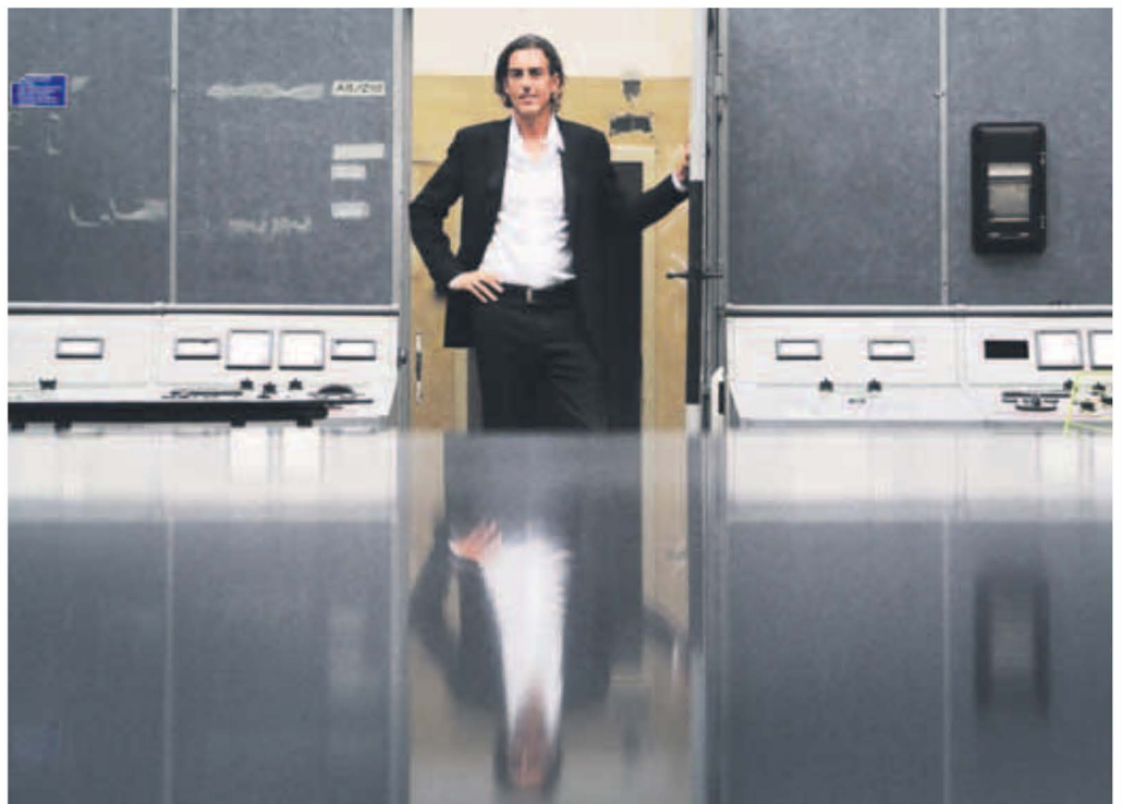
Immobilien-Sammler. Michael Tippin will das ehemalige Umspannwerk im Gleimviertel kreativ nutzen.
